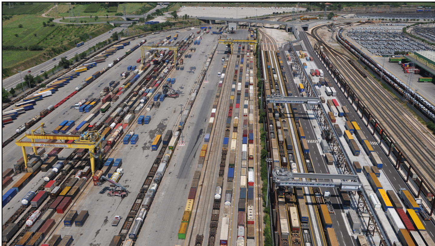
Il Terminal visto dall'alto
