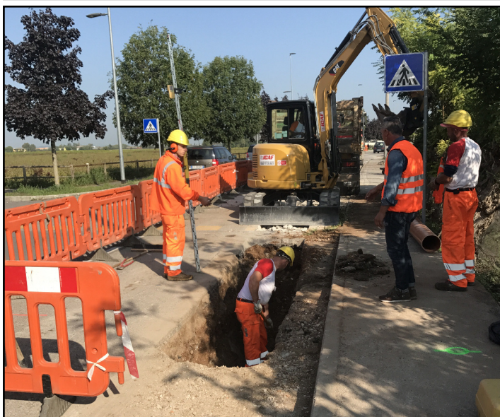
Niko Cordioli in sopralluogo al cantiere
