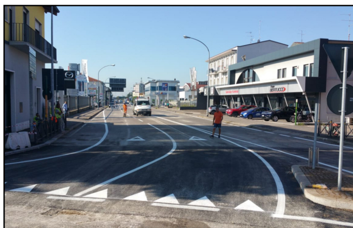
La conclusione dei lavori
