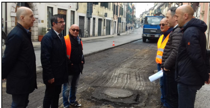
L'asfaltatura in via XX settembre
