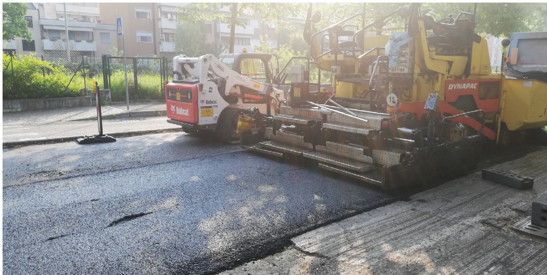
Asfaltatura in via Dalla Corte
