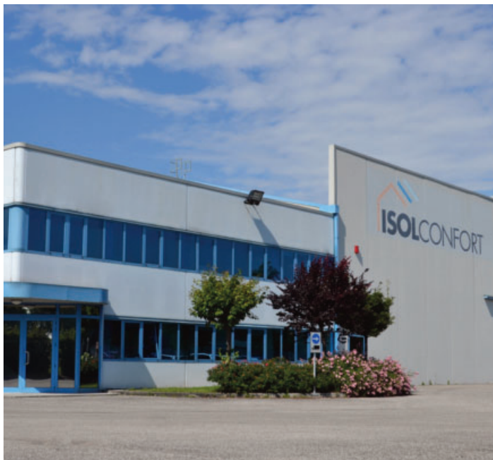
La sede di Isoconfort a San Vito al Tagliamento
