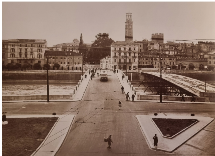
1939: due Ponte Nuovo per attraversare l'Adige
