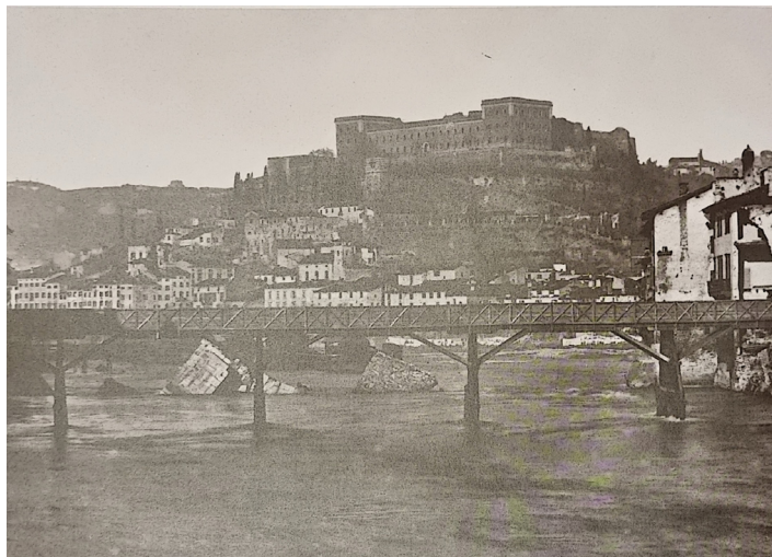
1882: Ponte Carli al posto di Ponte Nuovo dopo l'alluvione
