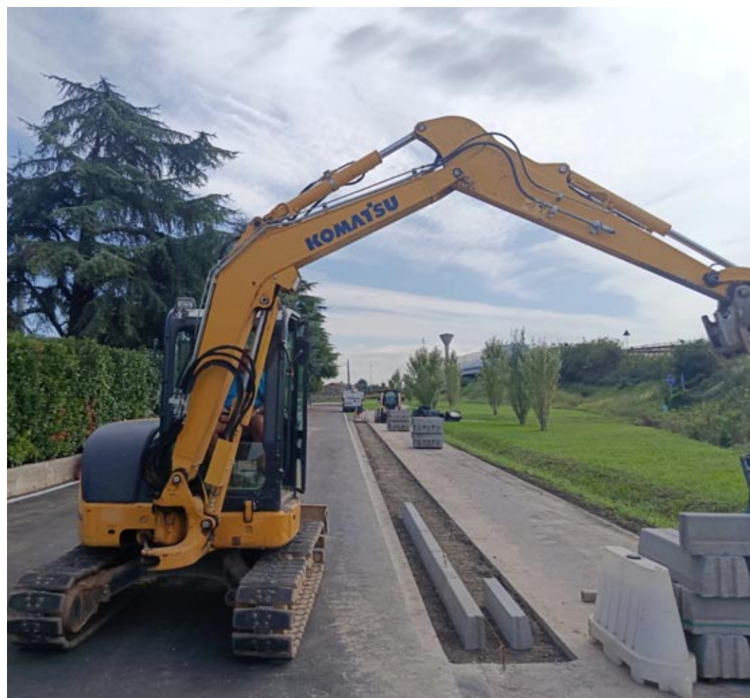
I lavori a Nogarole Rocca
