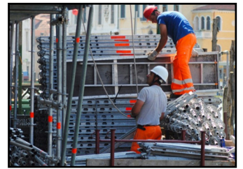
Un cantiere edile
