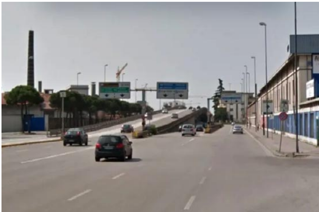
Partono i lavori per l'adeguamento statico del cavalcavia di Viale Piave
