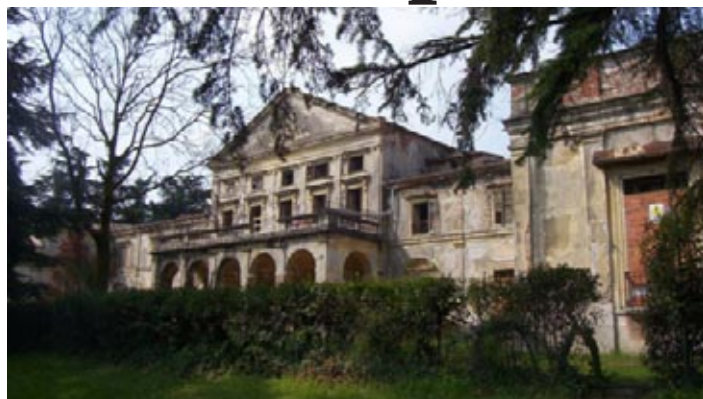
Villa Pullè al Chievo
