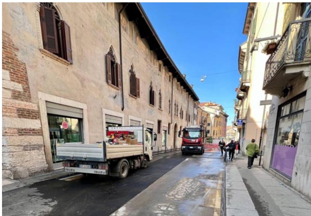
Terminati i lavori in Via San Paolo, viene ripristinata la viabilità
