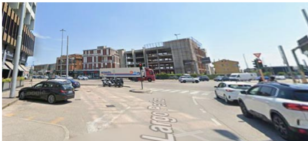
I lavori per la filovia stanno interessando Largo del Perlar
