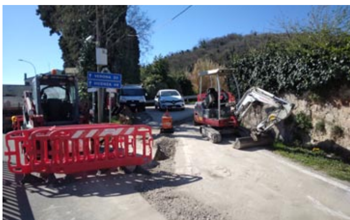
I cantieri a Roveredo di Guà e Mezzane di Sotto
