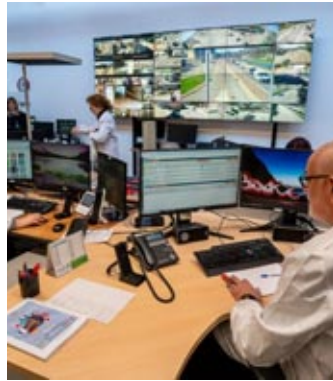
La sala di controllo
