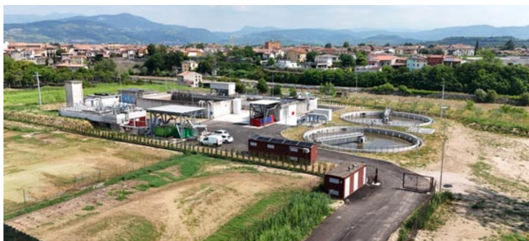
Il depuratore di Bussolengo
