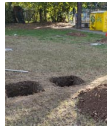
Il cantiere della nuova Popup Sport Zone
