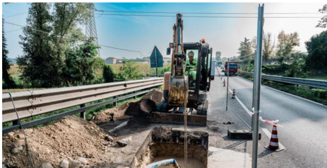
Il cantiere di Ags a Castelnuovo
