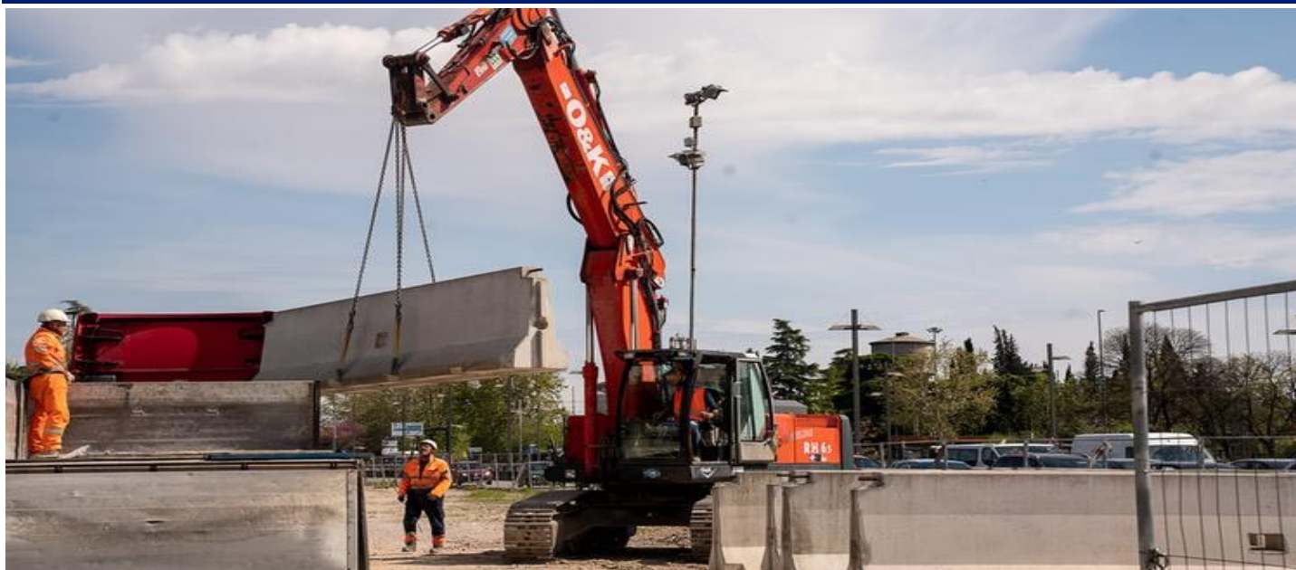
I lavori per il filobus in via Città di Nimes
