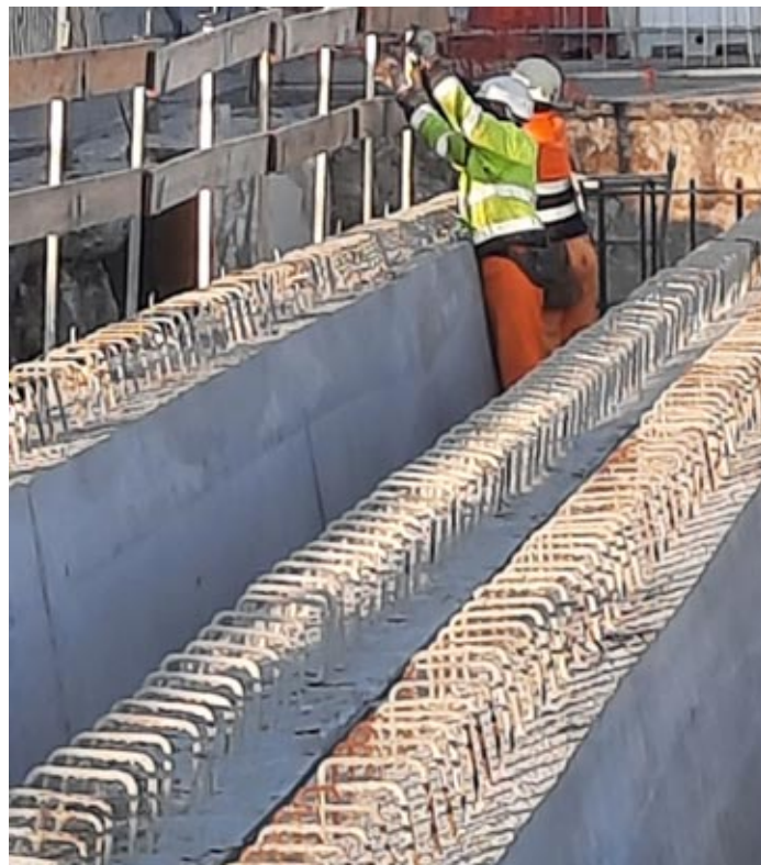
Gli operai al lavoro nel cantiere del sottopasso
