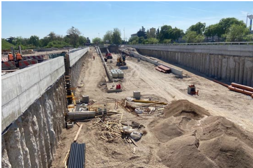
Il cantiere del sottopasso di via Dal Cero ancora in alto mare
