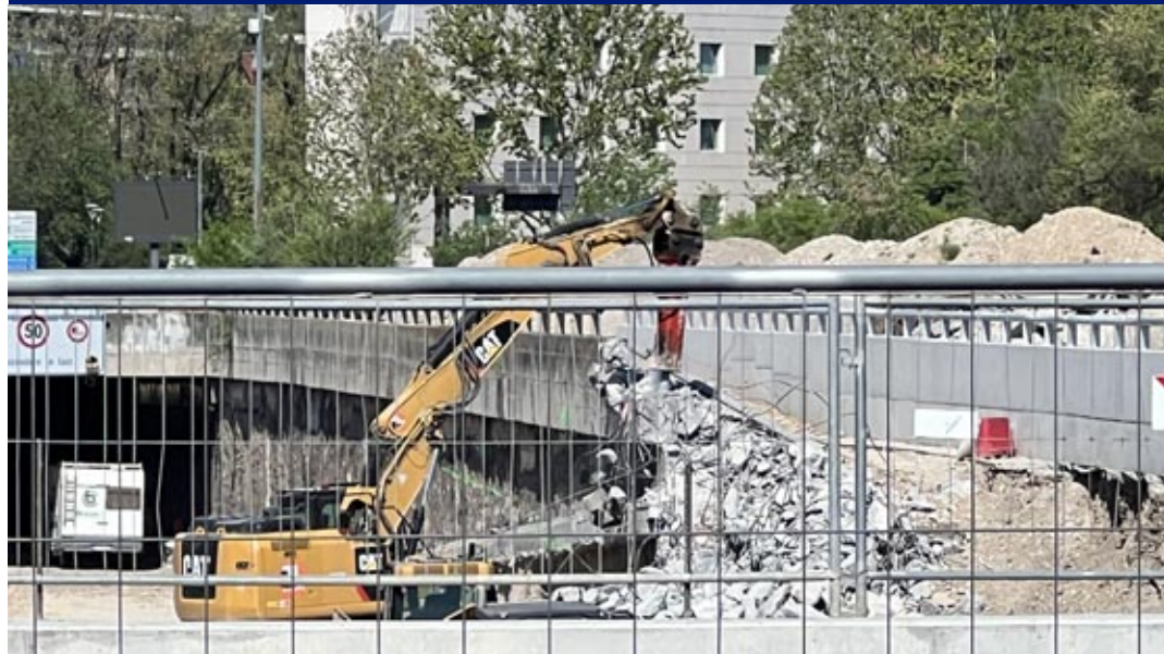
Ruspe al lavoro sui vecchi sottopassi
