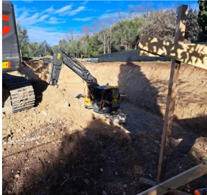
Lavori a Punta San Vigilio
