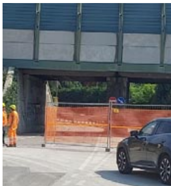
Il sottopasso di via Bernini Buri
