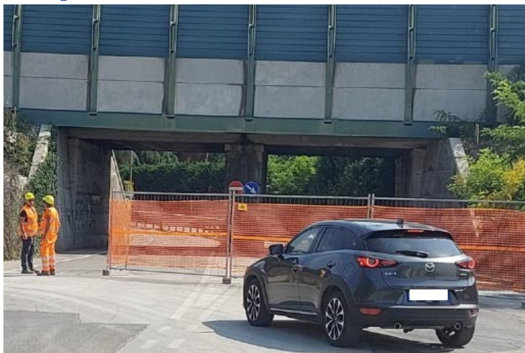
Il sottopasso di via Bernini Buri
