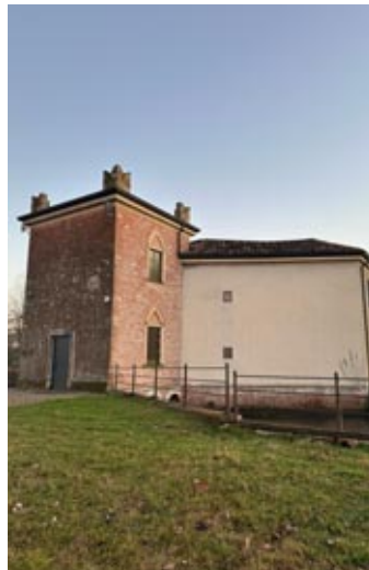
Il manufatto idraulico del Gangaion a Ronco all'Adige
