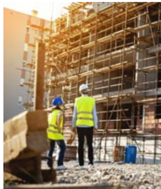
Un cantiere edile
