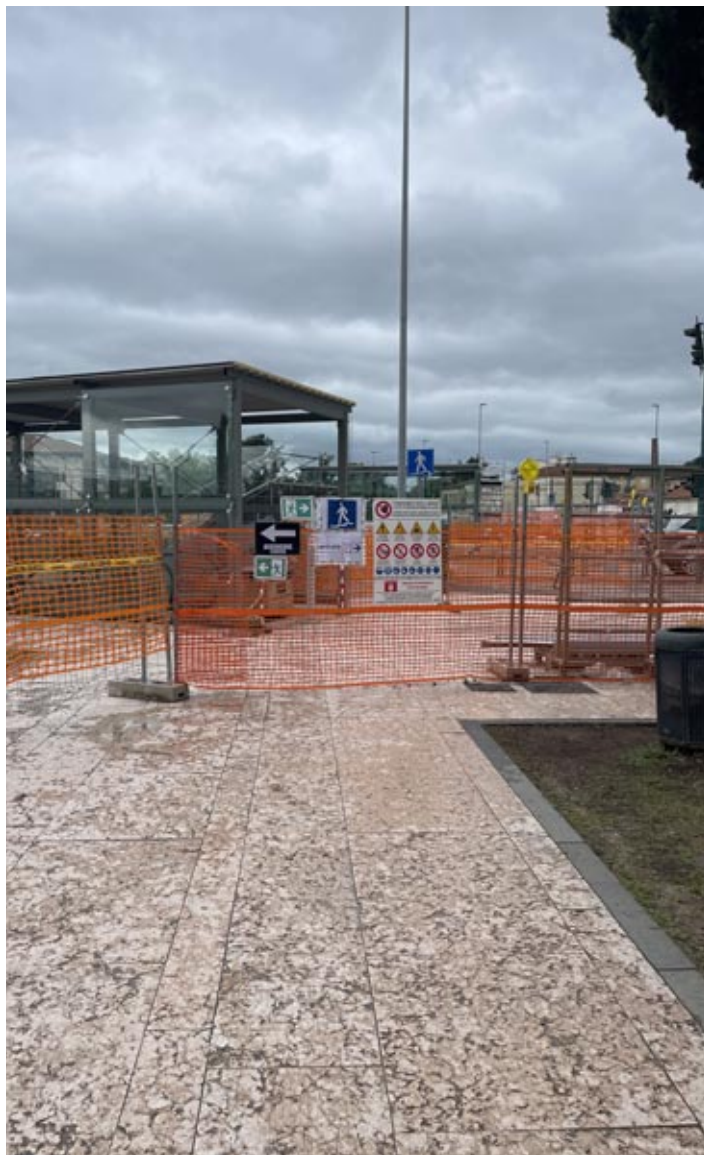
Il cantiere delle scale mobili del parcheggio Centro
