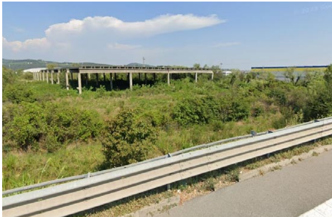
Una delle strutture esistenti nella zona della Campagnetta a San Michele Extra. Sotto, la vicesindaca Bissoli
