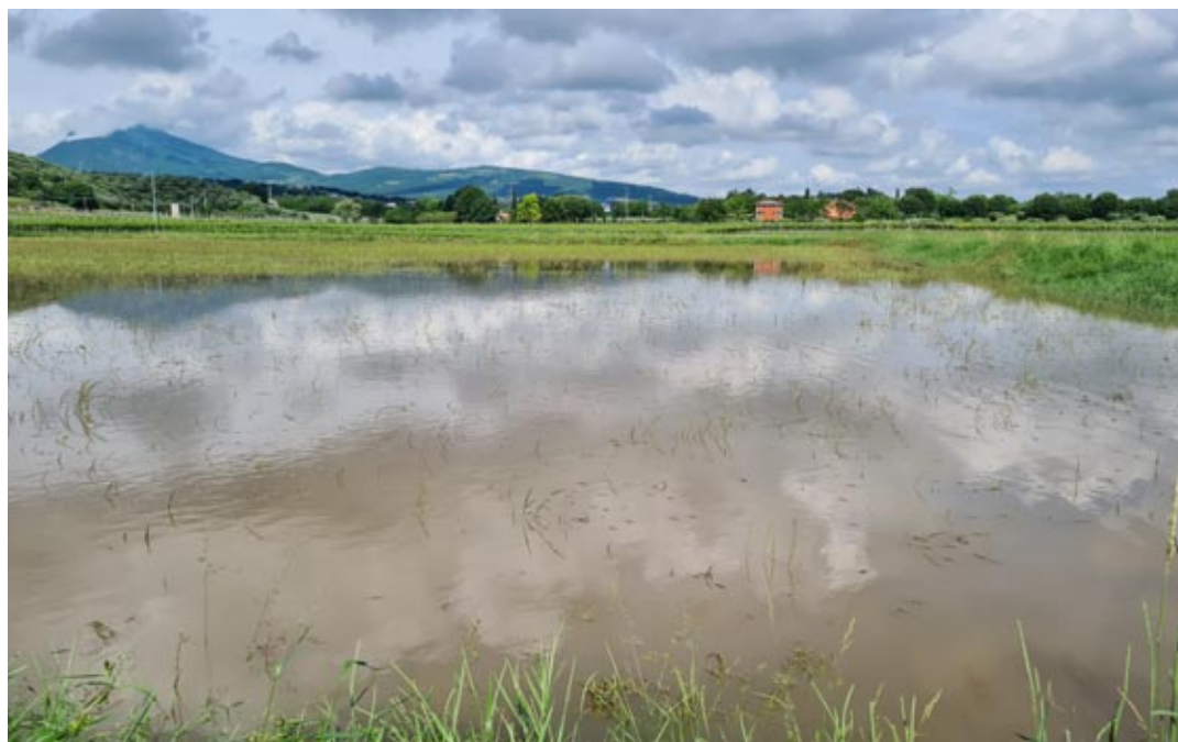
La vasca di laminazione realizzata dal Consorzio di Bonifica a Cavaion
