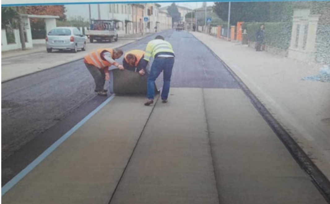
La posa della membrana di bitume in una strada di Trevenzuolo: allunga la durata dell'asfaltatura di 4 volte. Sotto, l'articolo della Cronaca di Verona dei giorni scorsi
