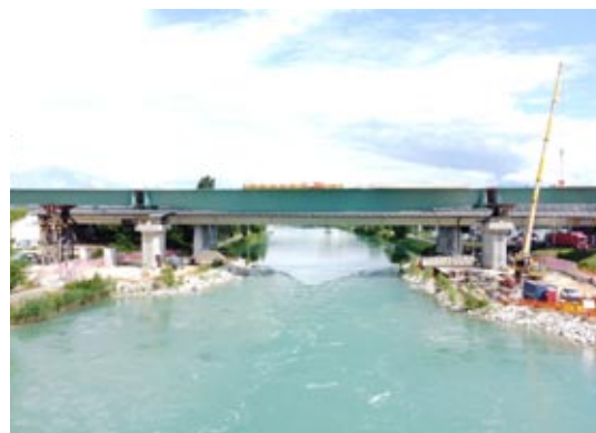
L'impalcato metallico del viadotto Mincio nel cantiere di Peschiera
