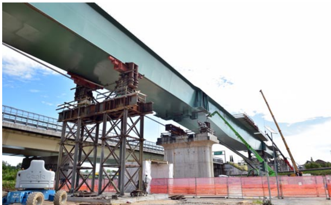
L'impalcato metallico del viadotto Mincio nel cantiere di Peschiera
