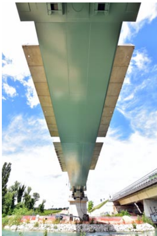
L'impalcato metallico del viadotto Mincio nel cantiere di Peschiera
