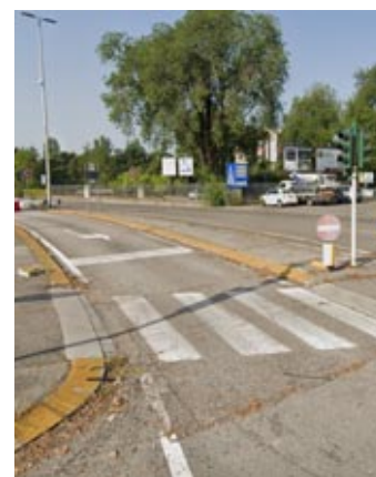
Viale Dal Cero
