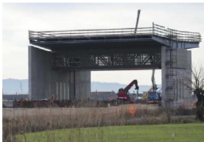
I lavori per il nuovo casello a Montecchio
