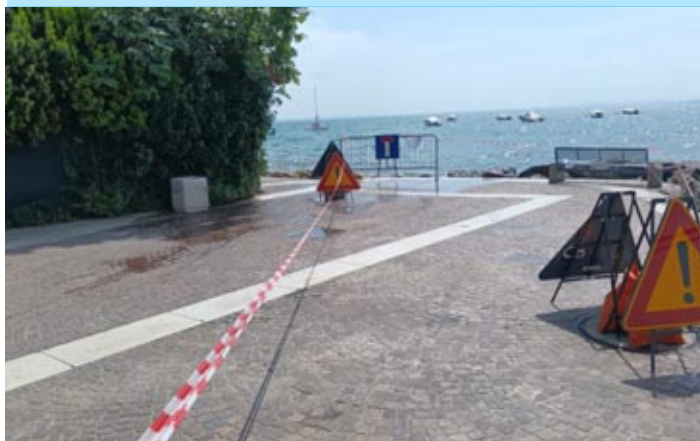
Piazza Lago a Cisano, dove oggi è iniziata la pulizia delle tubazioni e la situazione dei chiusini sta tornando pian piano alla normalità
