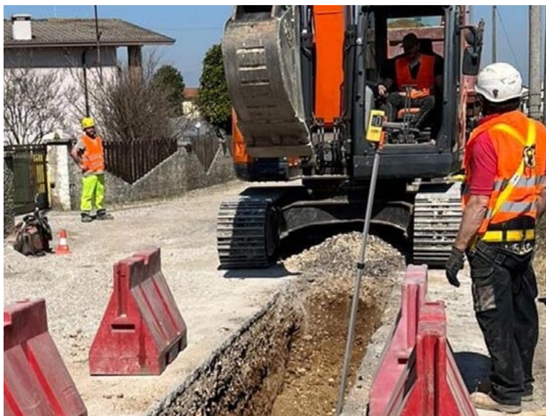
Un cantiere di Acque Veronesi
