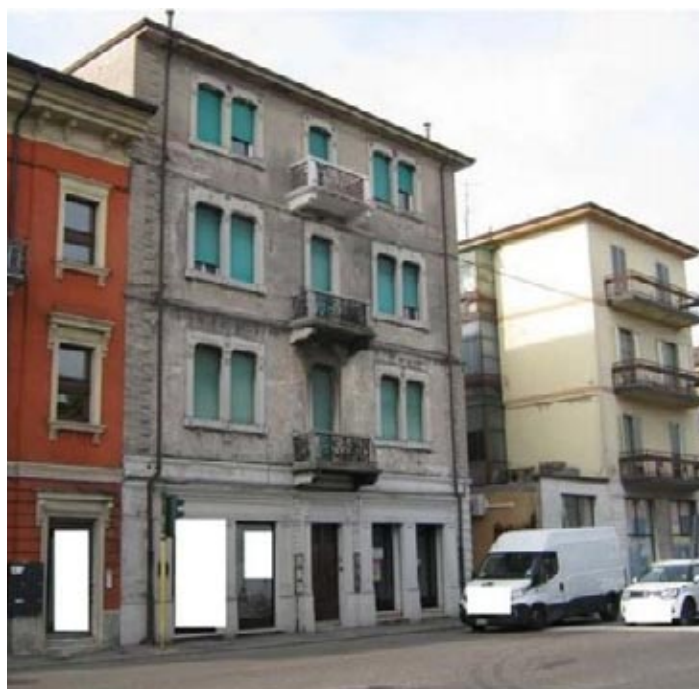
Edifici in Via Tombetta
