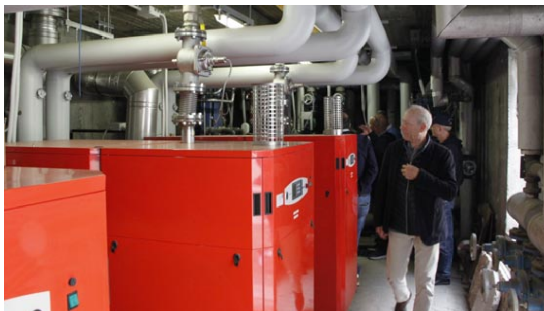
L'impianto composto da 3 generatori termici a condensazione installati presso la Scuola Allievi Agenti della Polizia di Stato di Peschiera del Garda. Sotto l'amministratore Cristiano Bistoletti e una foto dell'esterno della Scuola
