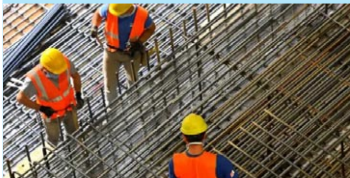
Operai in un cantiere edile
