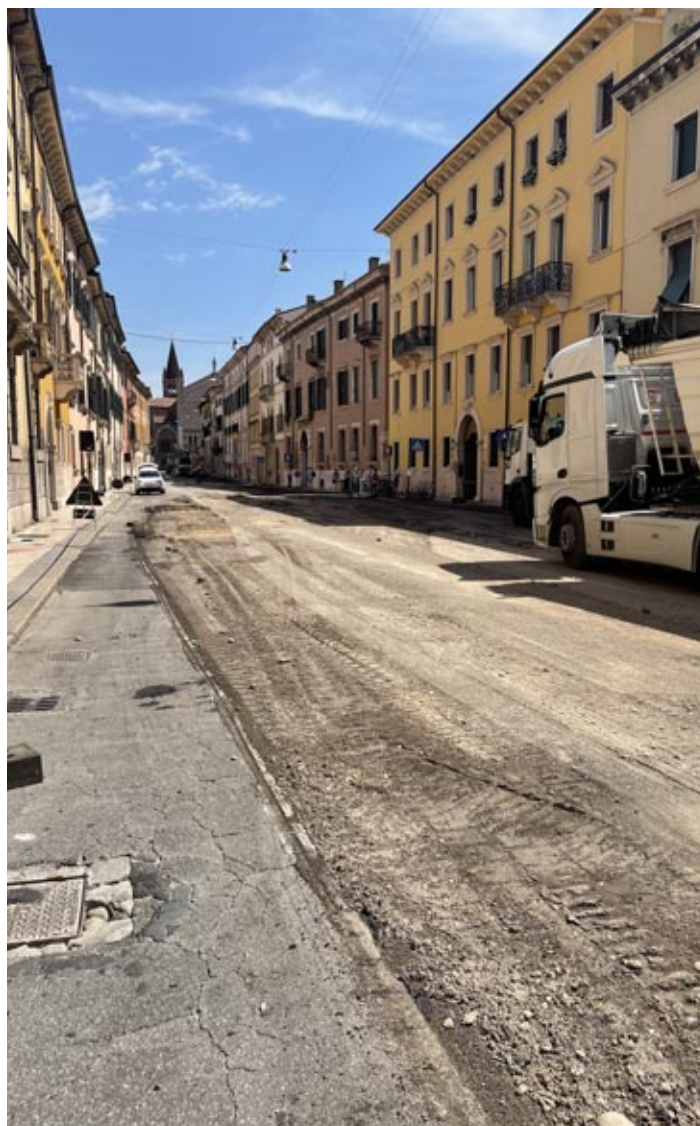
I lavori in Stradone San Fermo
