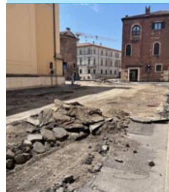
Il cantiere per i lavori
