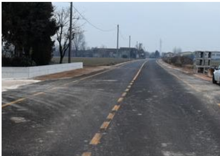
Riaperta la strada provinciale 20 tra Nogara e Salizzole
