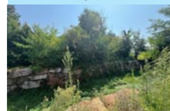
L'area del ponte di Avesa
