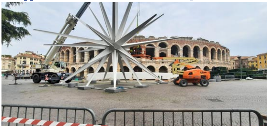
I lavori di rimozione della stella dopo il crollo
