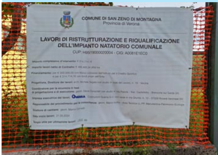
Il tabellone dei lavori
