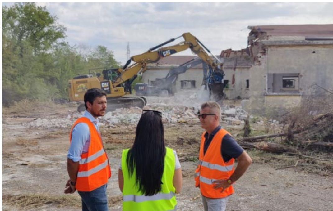
L'assessore Ferrari durante le demolizioni
