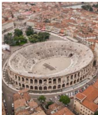
L'Arena chiusa per lavori
