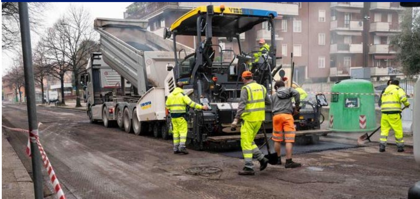
I lavori del filobus che hanno interessato via Pisano in Borgo Venezia
