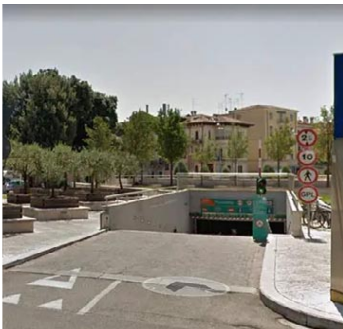
L'ingresso del parcheggio di Piazza Isolo
