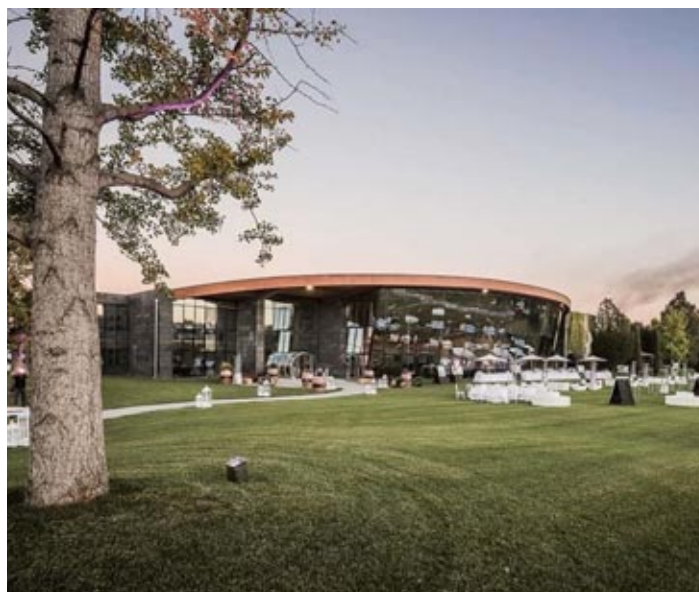
La Cantina Monteci a Pescantina ospita l'assemblea generale della filiera del legno
