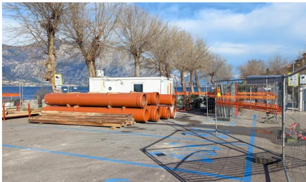
Il cantiere per il Collettore del Garda
