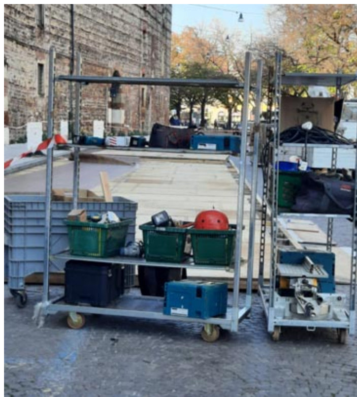
I lavori in via Pallone per i Mercatini di Norimberga
