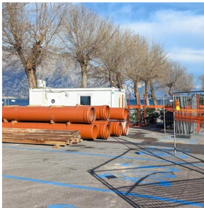
Il cantiere del Collettore a Malcesine
