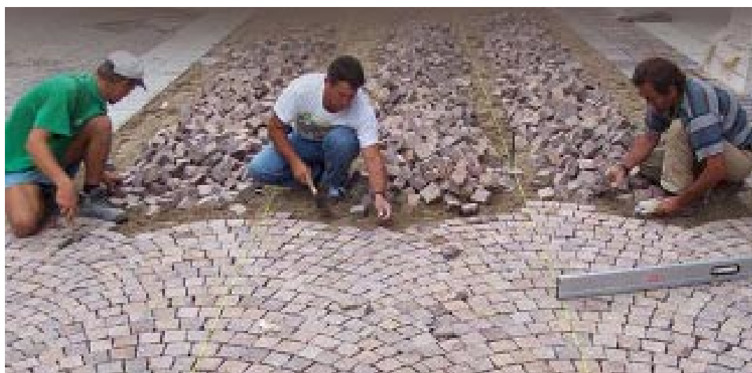
Per la prima volta saranno a servizio del Comune tre posatori di porfido esperti per il Centro Storico
