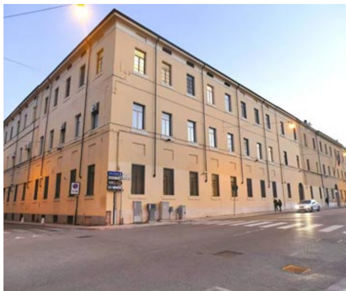
Nella Caserma Rossani si trasferirà la sede della Polizia Locale
